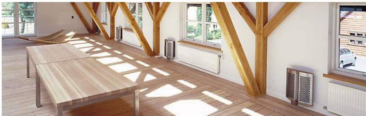
Figur 2 Comfort 100 fasadeventiler med varmebatteri og filter fra ITEK AS.
